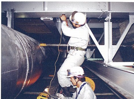
写真3 エコーチップによる硬さ測定
