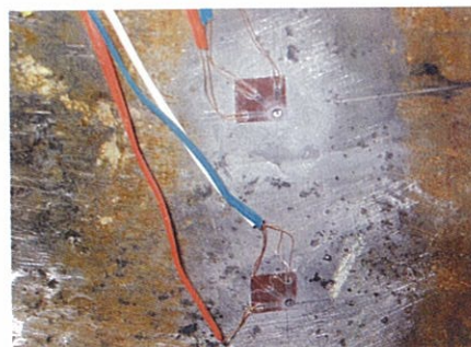
写真6 ひずみゲージによる残留応力測定
