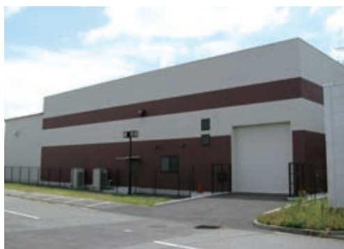
写真2 試験場外観(大型振動実験棟)
