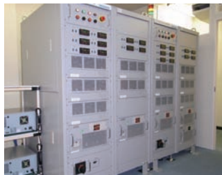
充放電試験機外観
