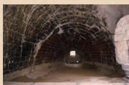
煙突の足元にある低い炉の天井に熱が反射して銑鉄を溶解することから反射炉の名がついた
