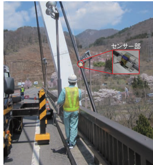
写真1 斜張橋ケーブルの渦流探傷法による測定状況
