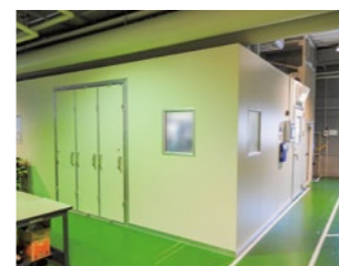
■写真1 スーパードライルームの外観
